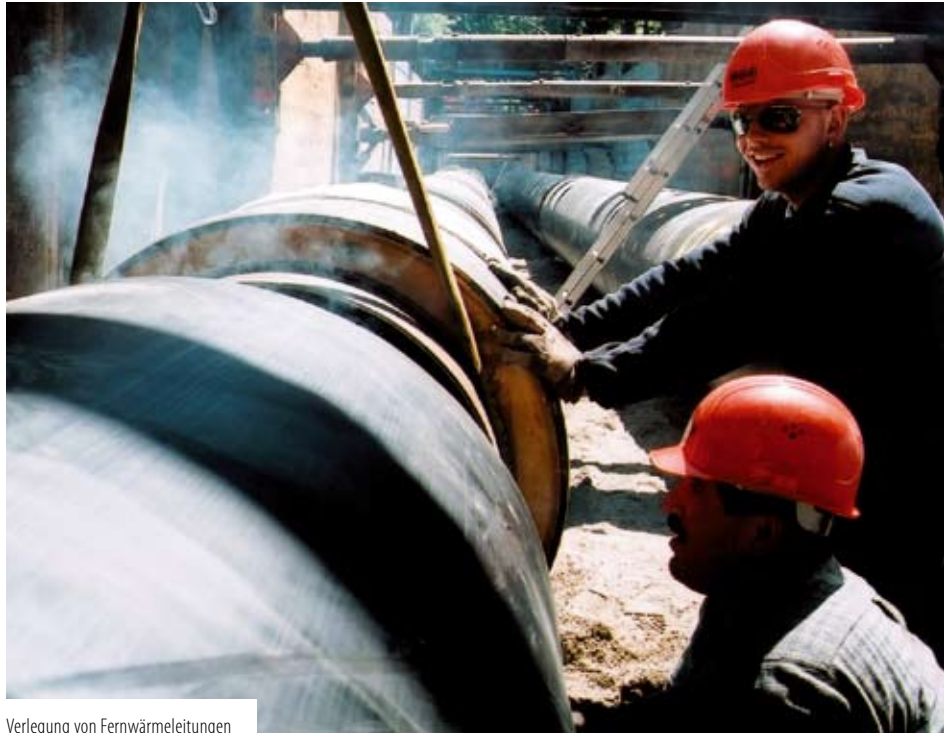
Verlegung von Fernwärmeleitungen
